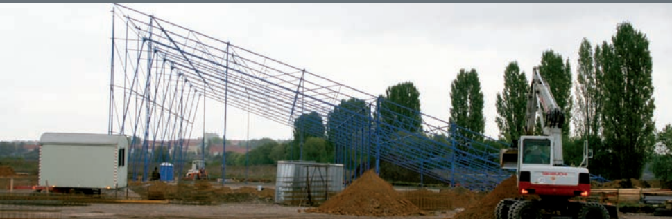
Erste Bauphase einer VEGA 3000-Halle in Sangerhausen
