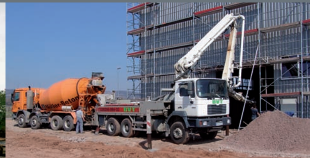
Betonierungsarbeiten an der VEGA 3000-Halle
