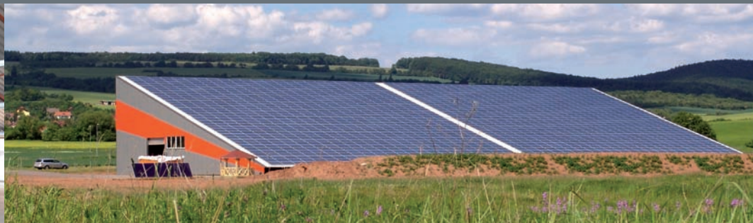
Südseite der VEGA 3000 - Halle
